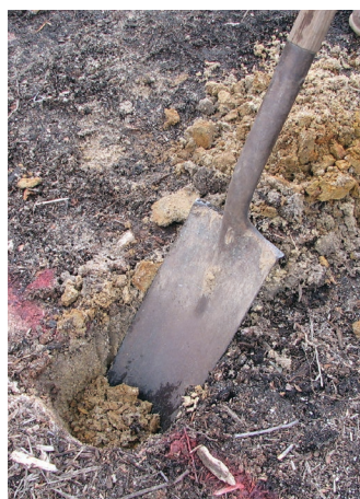
E. Dig holes for poles
