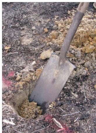
E. Dig holes for poles
